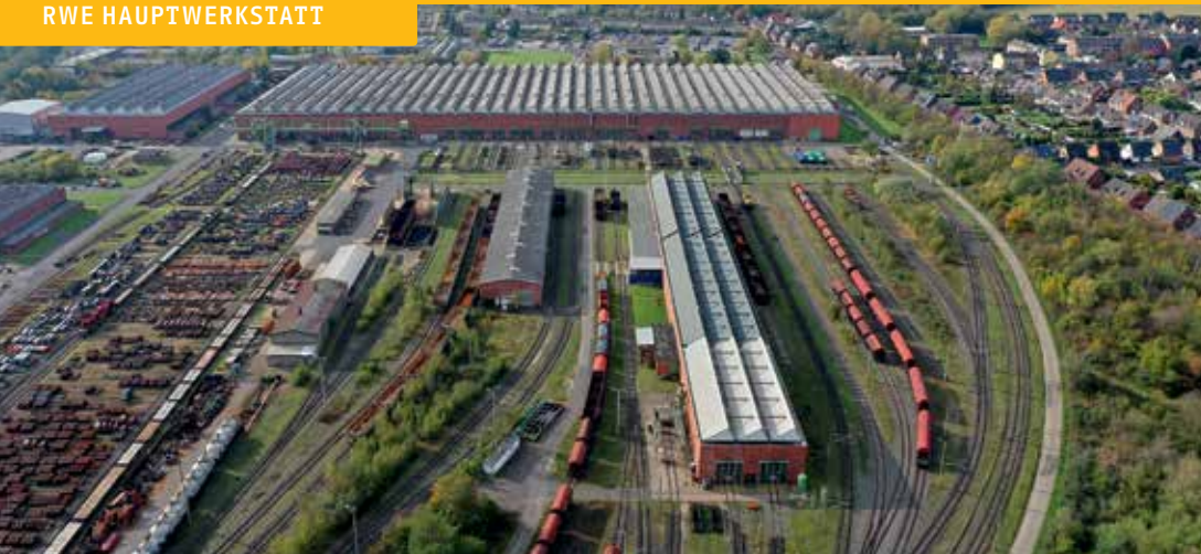
Luftaufnahme der Hauptwerkstatt Grefrath | Alle Fotos: © RWE Power AG
