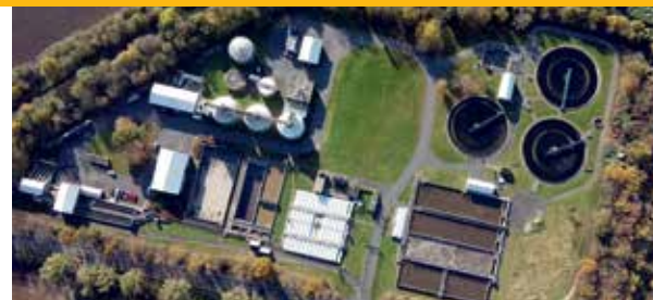
Nachklärbecken (li.), Luftbild des Gruppenklärwerks | Alle Fotos: © Erftverband
