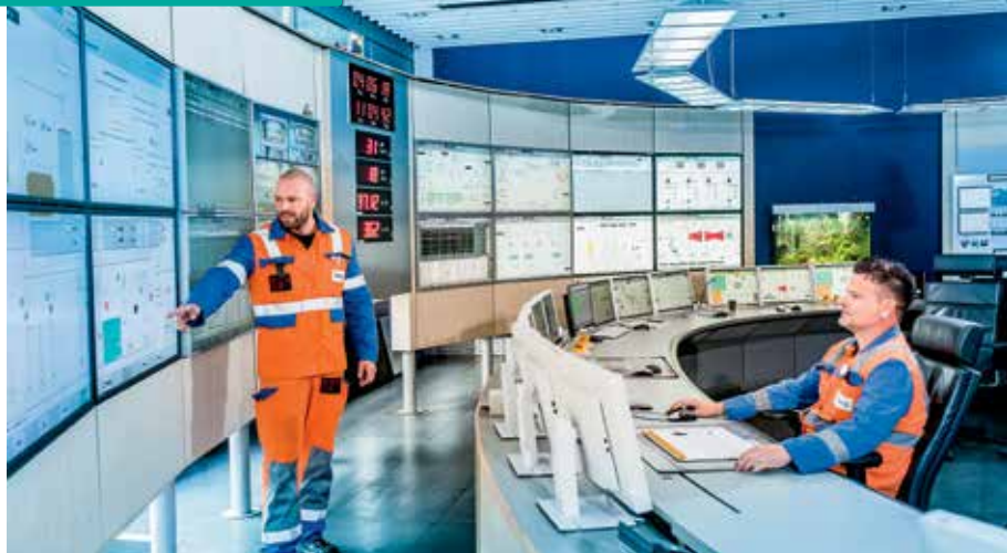
Schaltwarte Knapsacker Hügel | Alle Fotos: © RWE Power AG
